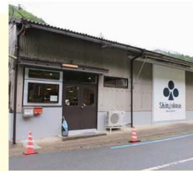
JA倉庫をリノベーションした外観
